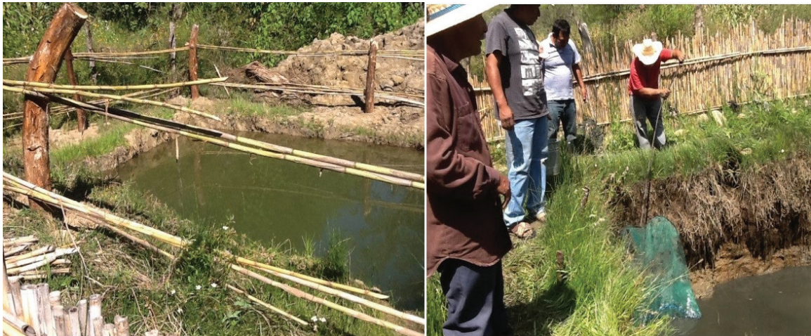
Figura 8. Habilitación de estanques rústicos. Fuente: Elaboración propia.
